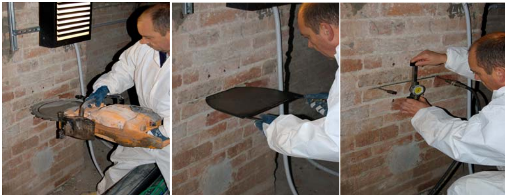
Figura 10: Taglio, installazione del martinetto e lettura della convergenza a cavallo del taglio
