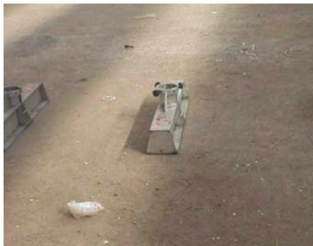
Figura 26: basi per la distribuzione del carico sui solai
