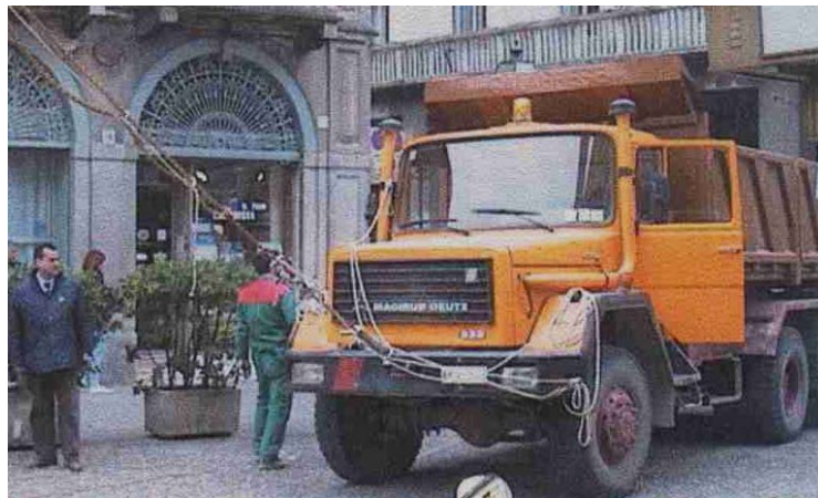
Figura 32: Autocarro utilizzato per il contrasto e cavo di tiro
