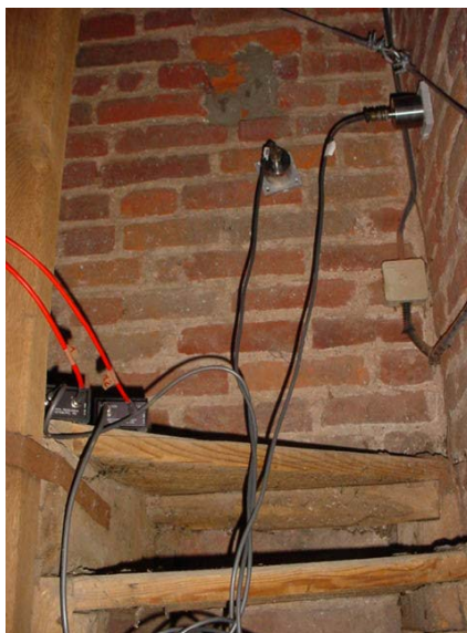
Figura 42: ubicazione degli accelerometri per la prova dinamica
