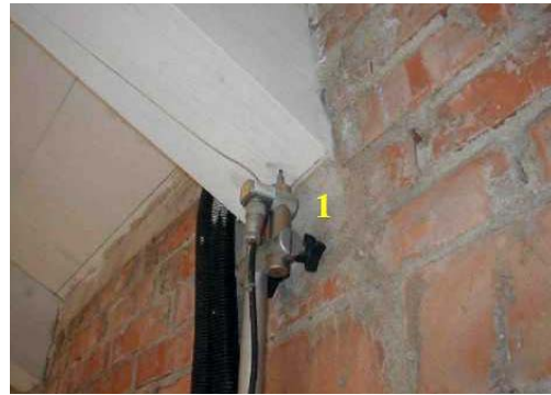
Figura 30: Trasduttore all'appoggio
