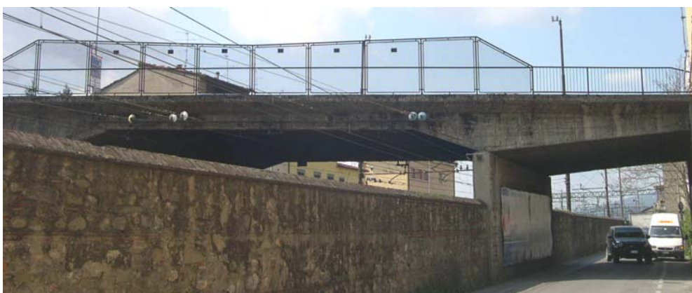
Fig. 1: Vista del viadotto dell'Arca a Pistoia
