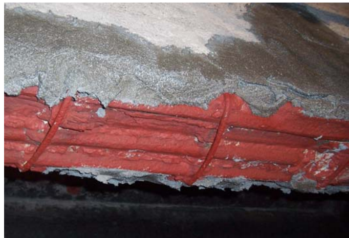
Fig. 18: Vista delle armature dopo il trattamento anticorrosione
