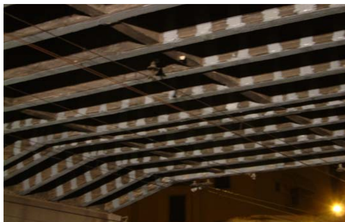
Fig. 21: Vista del ponte con i rinforzi quasi completamente montati
