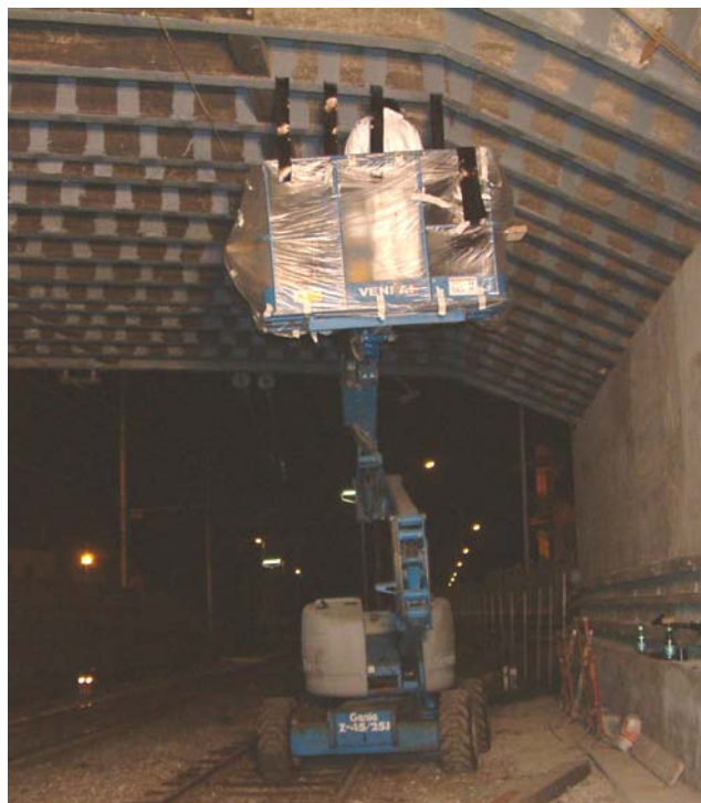
Fig. 20: Il montaggio dei rinforzi avviene con un mezzo elevatore di notte nei periodi di fermo del transito dei convogli ferroviari
