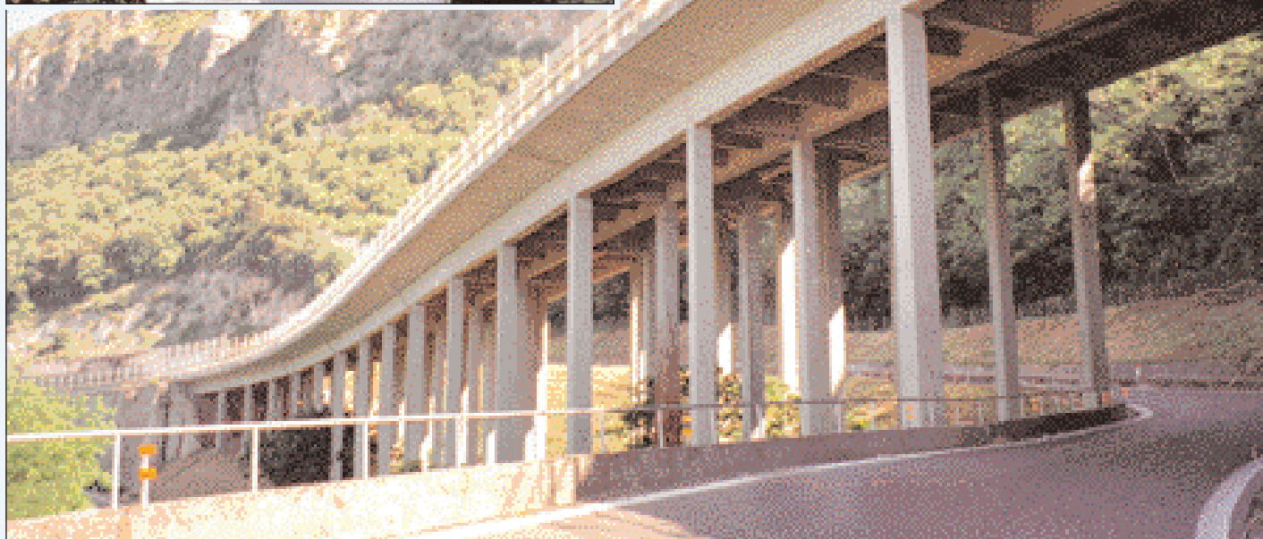
Foto 3 - Il viadotto su pile (senza arco e setti)
