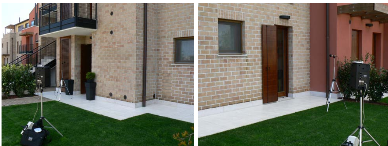
- misura 06 – facciata frontale
