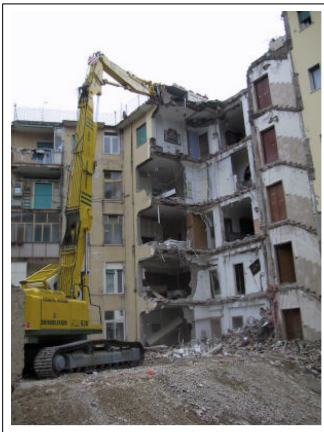
Fotografia 4. Le operazioni dalla piattaforma di lavoro
