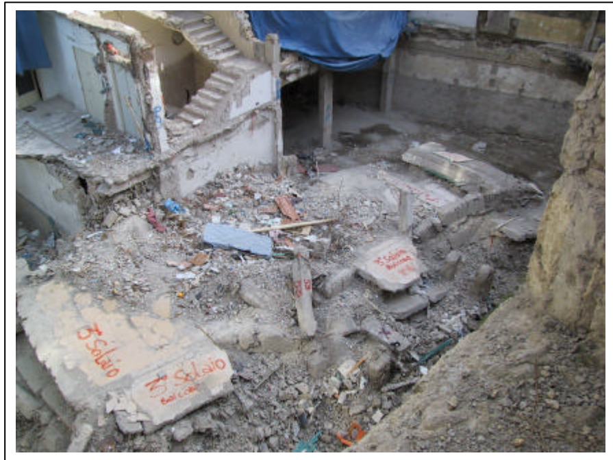
Fotografia 6. L'individuazione di uno degli impalcati crollati
