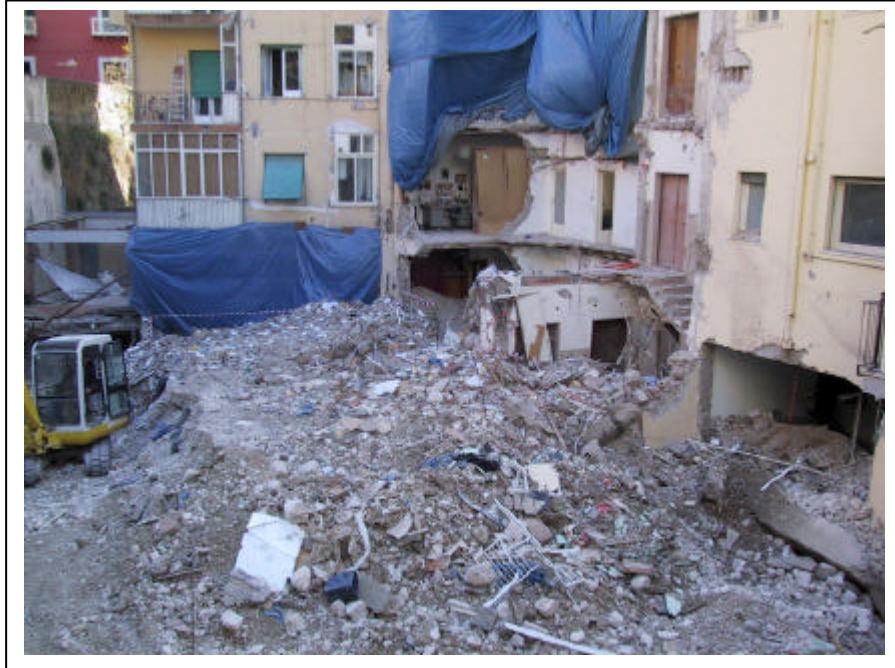
Fotografia 5. Una fase della rimozione delle macerie
