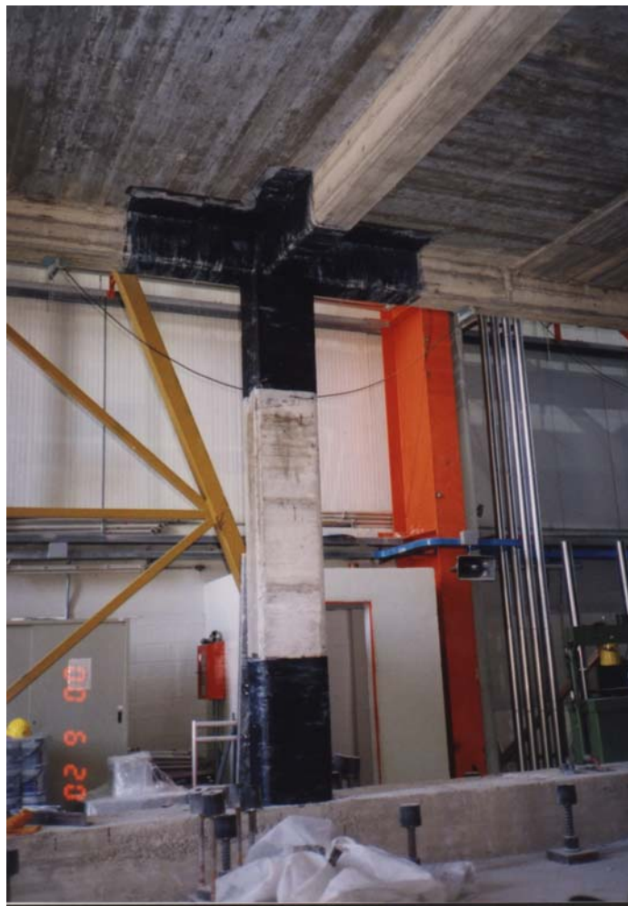
Figura 17. Fasciatura dei pilastri interni con fogli uniassiali
