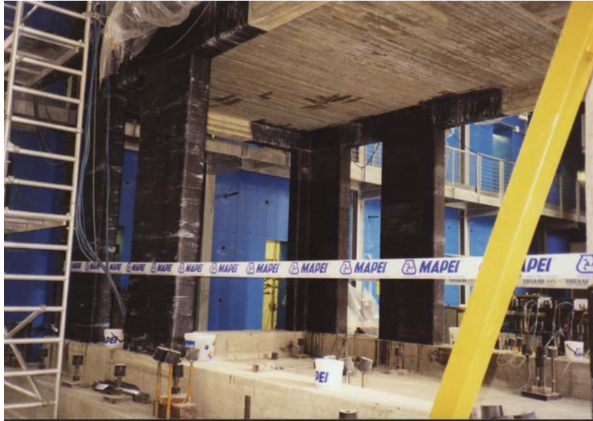
Figura 16. Riparazione dei setti mediante l'utilizzo di fogli quadriassiali
