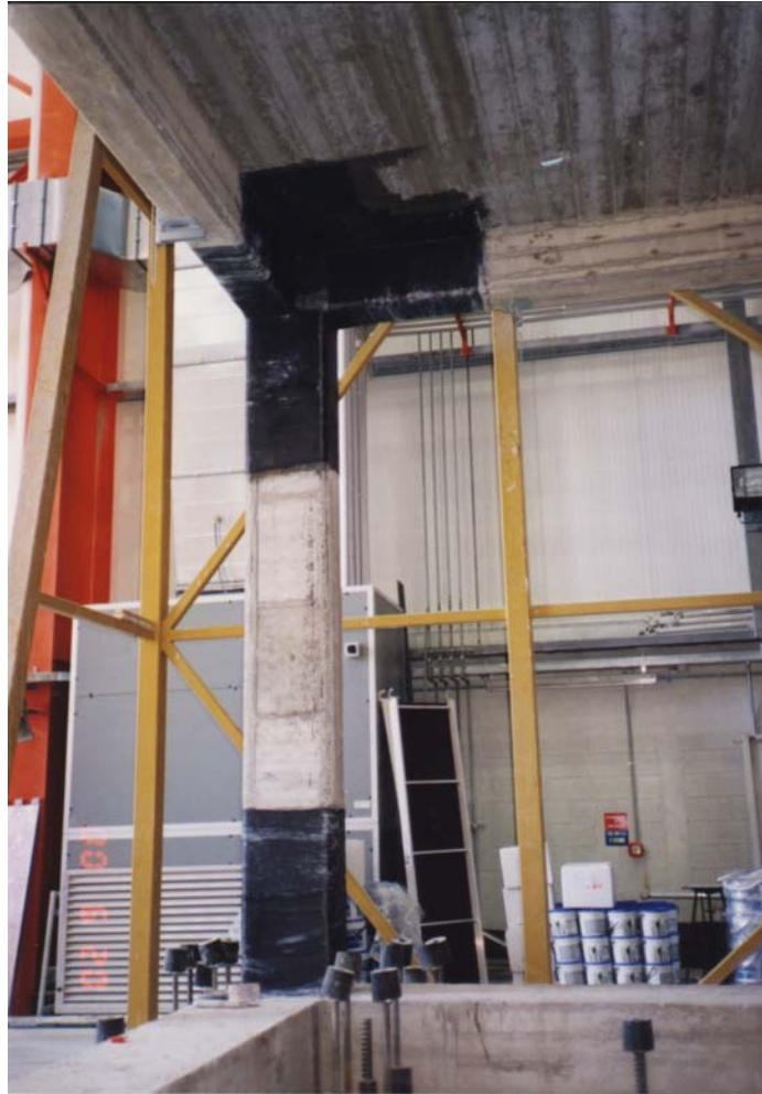
Figura 18. Fasciatura dei pilastri esterni con fogli uniassiali
