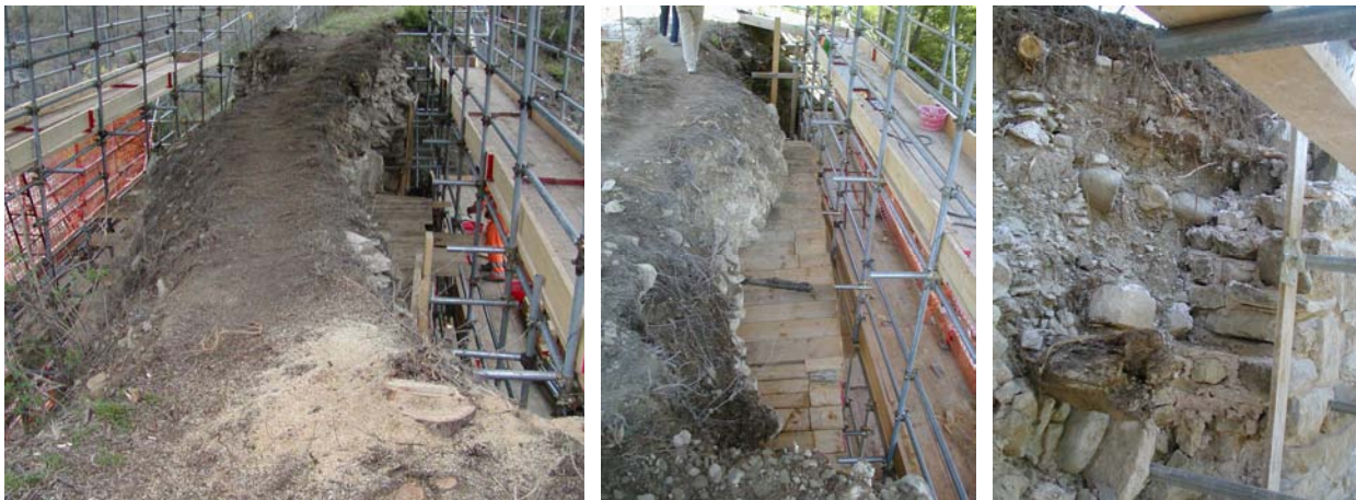
Figura 35. Immagini di cantiere: situazione precedente agli interventi di ricostruzione delle porzioni crollate di volta e di muri di testa.
