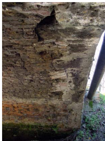
Figura 38. Immagini di dettaglio della volta muraria portante
