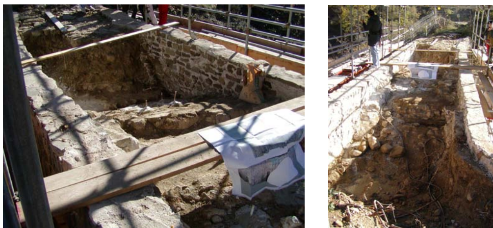
Figura 36. Immagini di cantiere: situazione riscontrata al termine della fase di rimozione dei rinfianchi.
