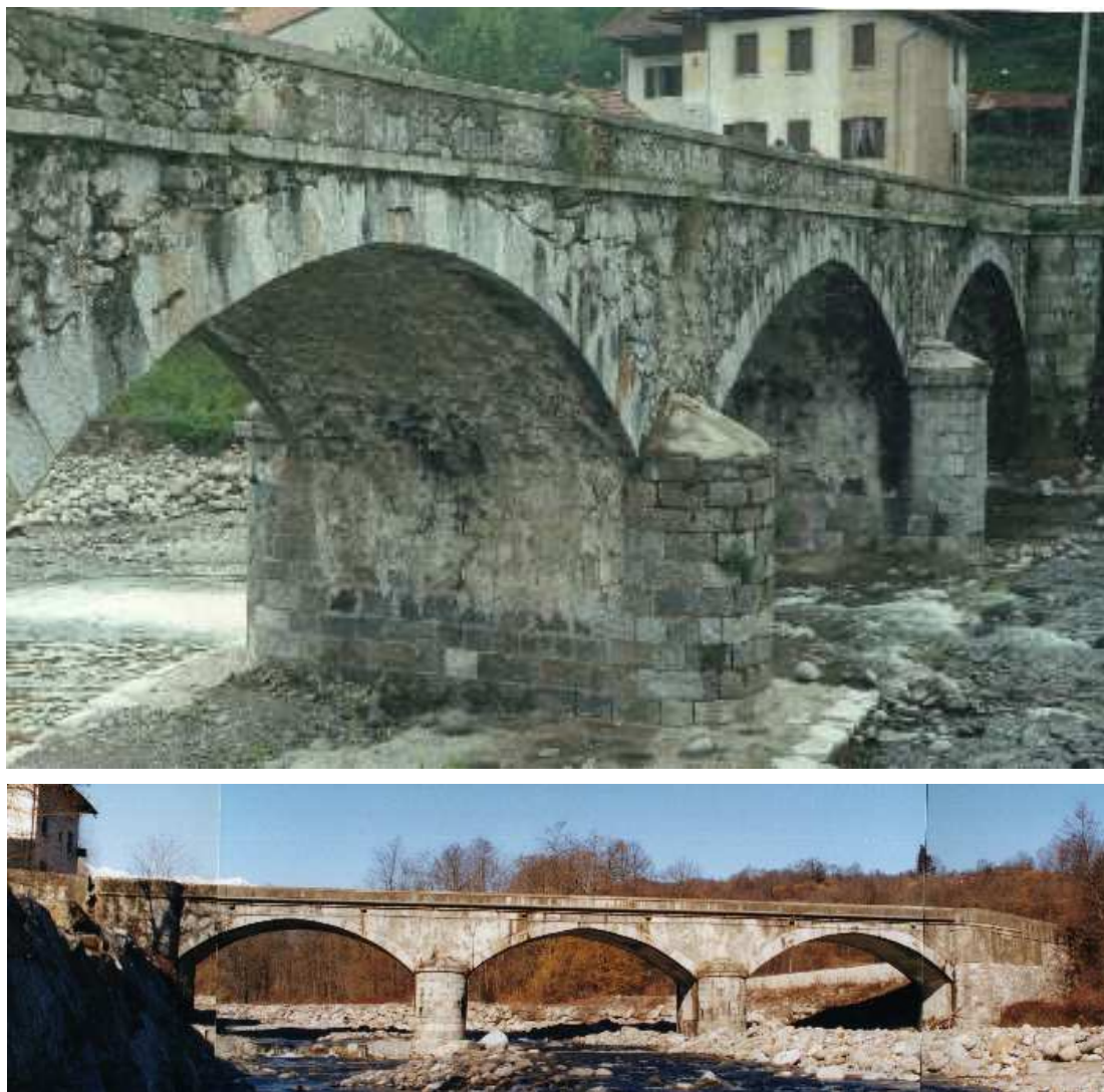
Figura 23. Viste del ponte
