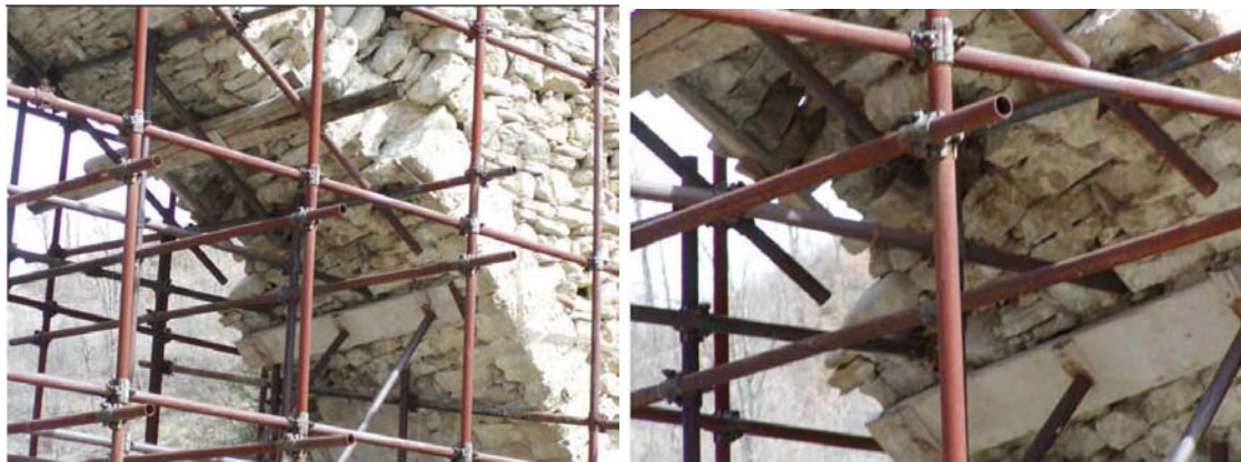
Figura 33. Situazione precedente l'intervento di presidio.
