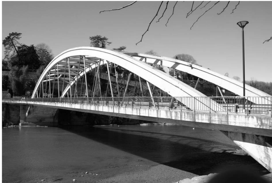
Figura 1a: Vista del ponte ad arco in c.a. di Canonica d'Adda (G. Krall, 1955)
