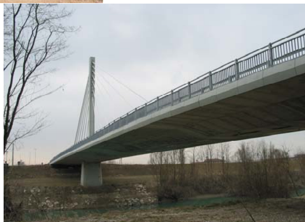
Fig. 8 – Il ponte sul fiume Livenza, presso Meduna (Tv).
