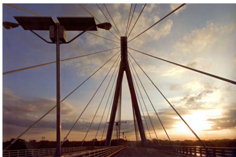
Fig. 10 – Il ponte sul rio Higuamo.
