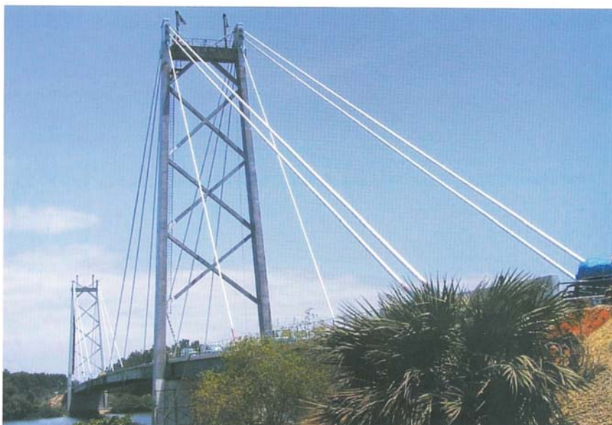
Fig. 7 – Il ponte sul fiume Kwanza, dopo gli interventi di recupero strutturale.
