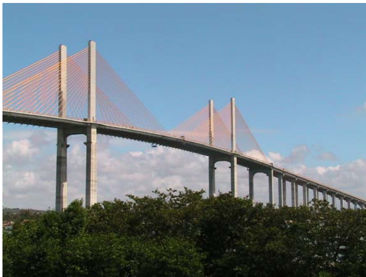
Fig. 9 – Il ponte sul rio Potengi a Natal.
