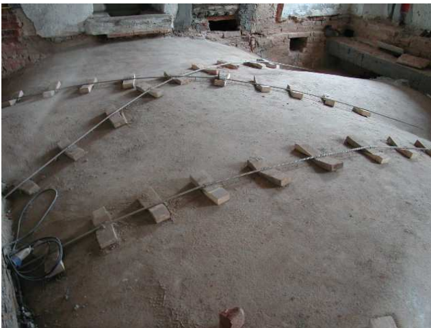
Figure 24 e 25 - Intervento con “arco armato” al Monastero degli Olivetani di Nerviano. (MI) : volte consolidate con cavi messi in trazione mediante cunei
