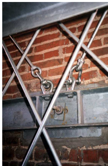
Figura 2 Confinamento della muratura tramite tiranti inseriti nelle buche pontate: schema e vista dall'esterno della piastra inox di ancoraggio. Figura 3 La “torre nella torre” vista dall'interno, particolare dei pendini e degli anelli perimetrali.
