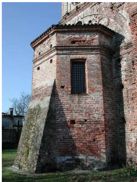
Figura 8 Contrafforte in muratura a contrasto delle spinte esercitate da una cupola spingente, Oratorio di S.Biagio a Rosate (MI)
