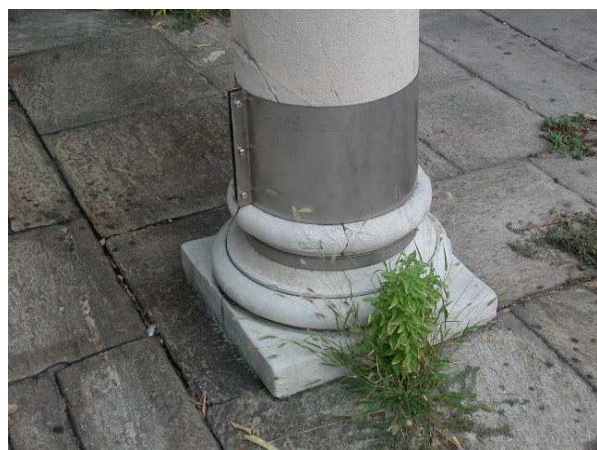
Figura 16 Anello di cerchiatura di colonna in pietra, fortemente degradato
