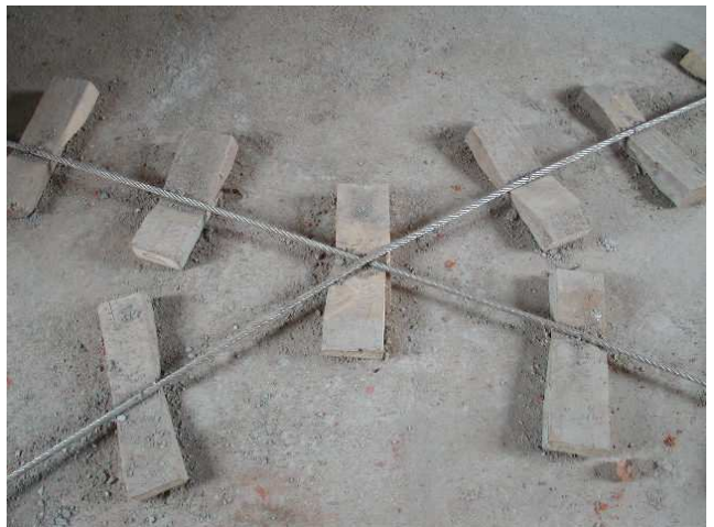
Figure 24 e 25 - Intervento con “arco armato” al Monastero degli Olivetani di Nerviano. (MI) : volte consolidate con cavi messi in trazione mediante cunei
