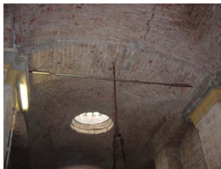
Fig. 10 – la catena al termine della posa
