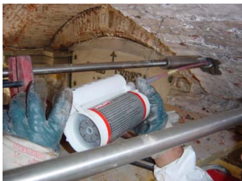
Fig. 9 – Particolare della fase di inghisaggio della barra filettata nella muratura
