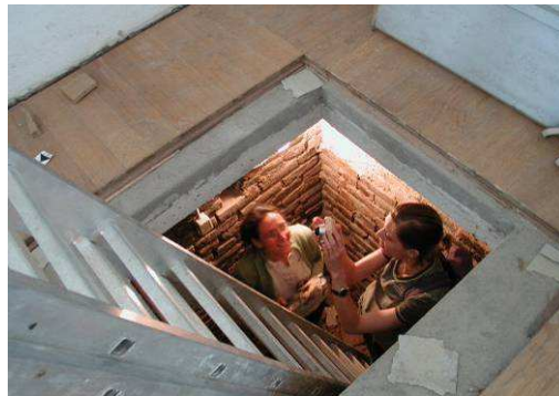
19. Immagini della botola di accesso all'intercapedine tra solaio e volta.
