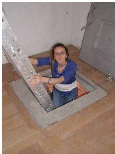
19. Immagini della botola di accesso all'intercapedine tra solaio e volta.
