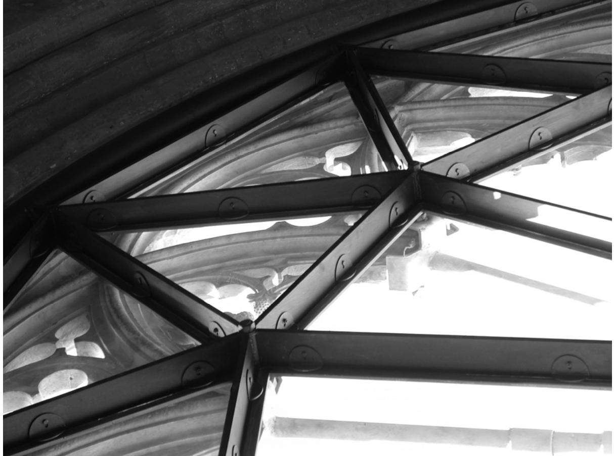
Immagini di dettaglio dell'intervento al termine dei lavori
