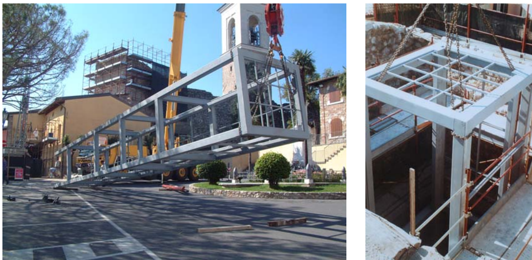
Figura 2 a, b. Fase di montaggio della gabbia metallica.
