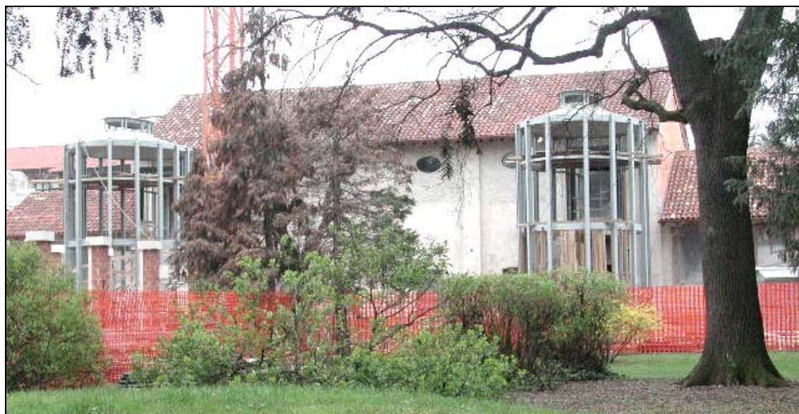
Figura 11. Torri metalliche in fase di realizzazione
