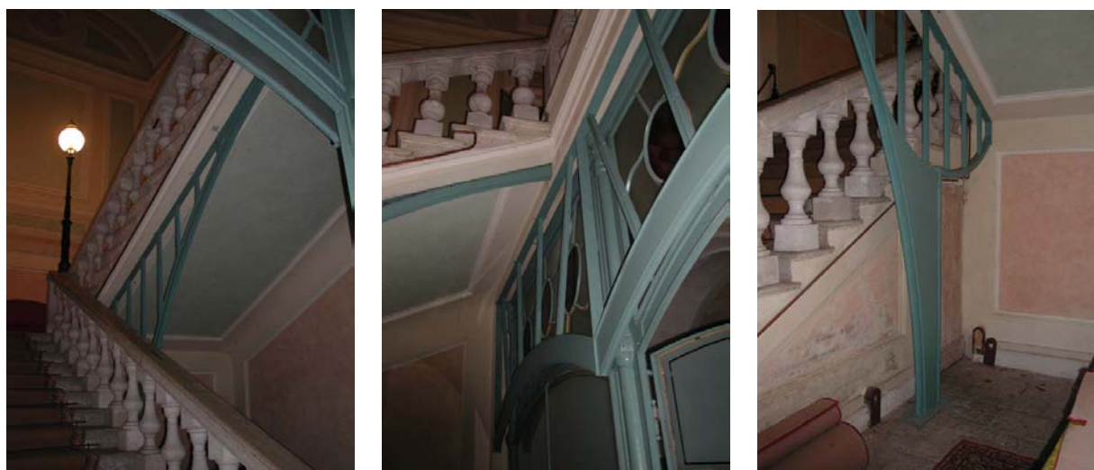
Figura 7. Consolidamento dello scalone principale. a) Vista del profilo ad arco rampante; b) particolare alla rampa superiore; c) particolare nella zona inferiore.
