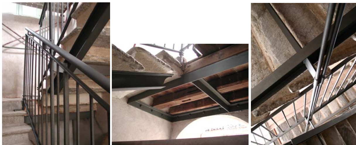
Figura 10. Consolidamento della scala esistente: dettagli
