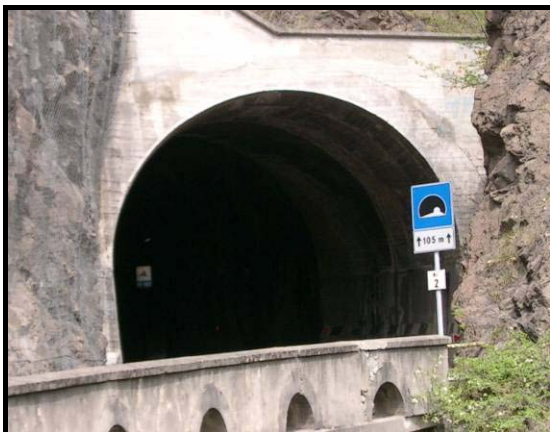
Fig. 10: galleria con limiti di altezza
