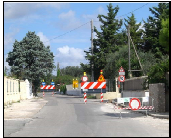
Fig. 9: restringimento di carreggiata
