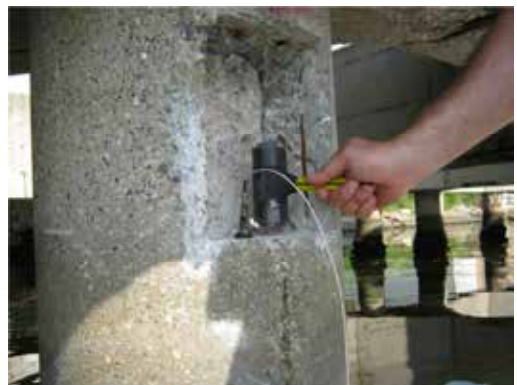
Impulso e accelerometro in nicchia
