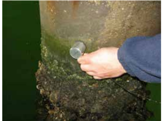
Acquisizione ultrasonica su fusto del palo
