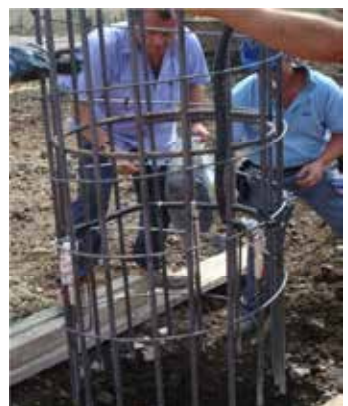
Collegamento dei sensori
