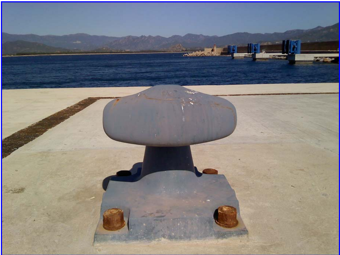
Vista generale zona di intervento
