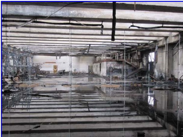
Foto 3: Panoramica della prova di carico
