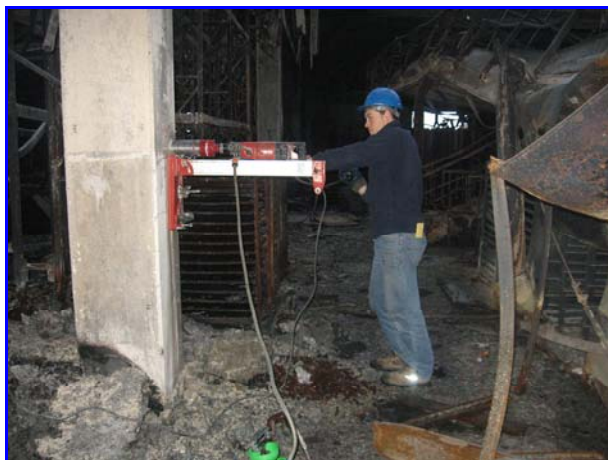
Foto 5: Carotaggio su pilastro in c.a.
