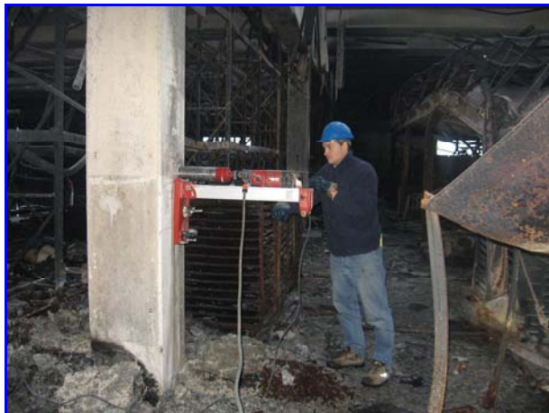
Foto 7: Carotaggio su pilastro in c.a.
