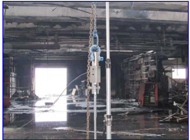
Foto 2: Cella di carico su pistone
