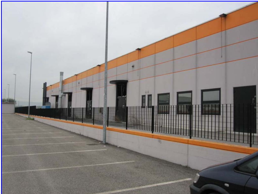
Lato ovest del capannone industriale della XXXXXXXXXXXX (MN)
