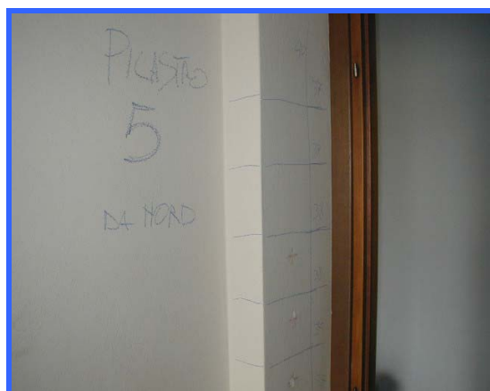
Individuazione ferri d'armatura P5
