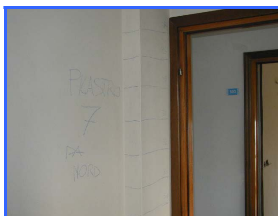
Individuazione ferri d'armatura P7
