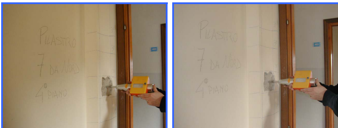
Esecuzione della prova sclerometrica
