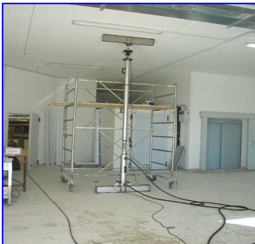
Foto 6 : applicazione del carico
