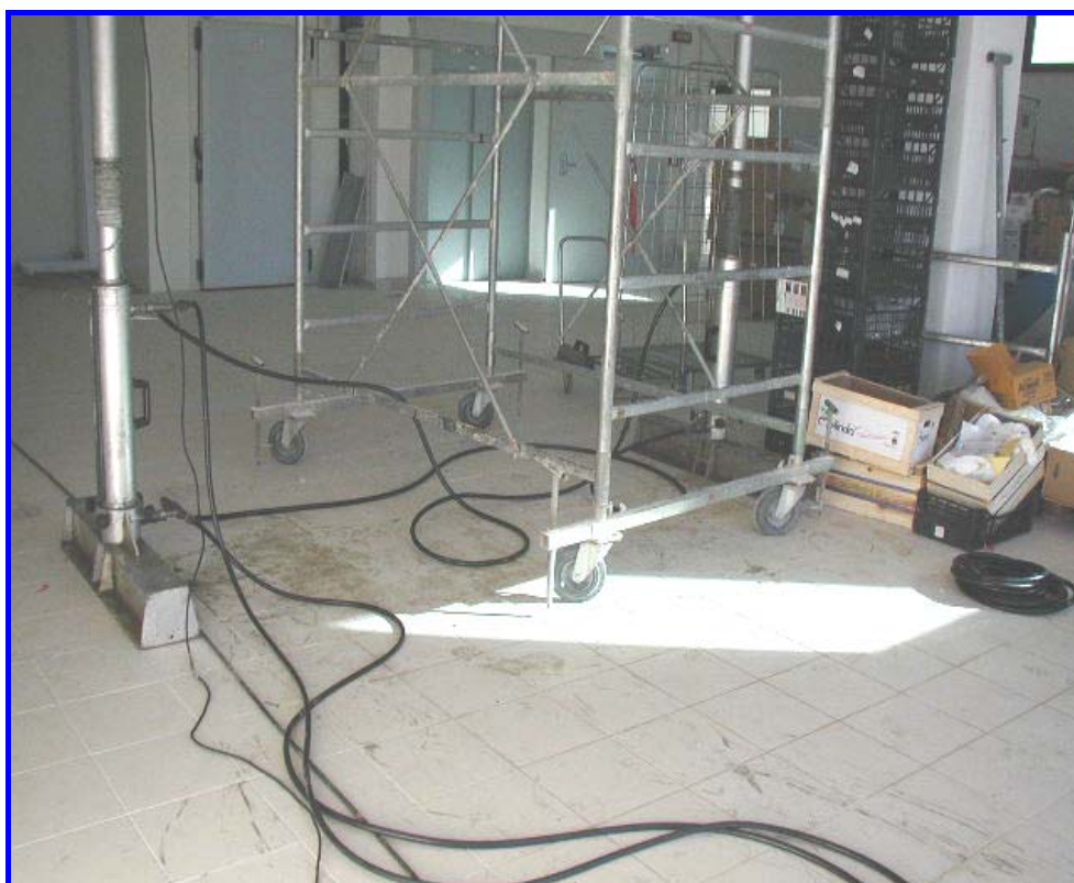
Foto 4 : applicazione del carico
