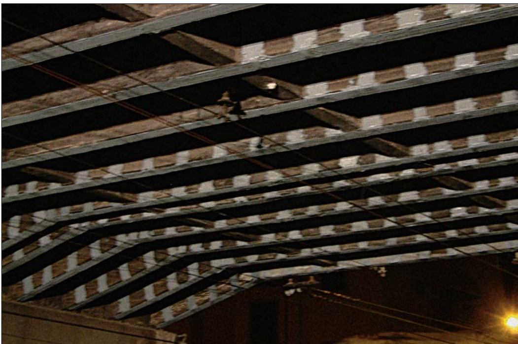
Fig. 21: Vista del ponte con i rinforzi quasi completamente montati
