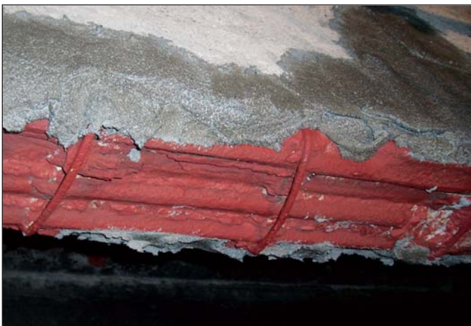
Fig. 18: Vista delle armature dopo il trattamento anticorrosione
