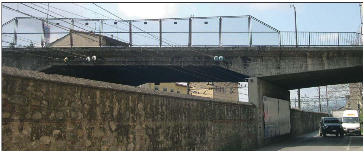
Fig. 1: Vista del viadotto dell'Arca a Pistoia
