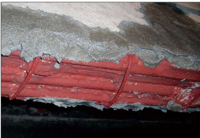
Fig. 18: Vista delle armature dopo il trattamento anticorrosione
