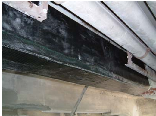
Figura 10. Intervento di rinforzo in composito: nastri longitudinali
