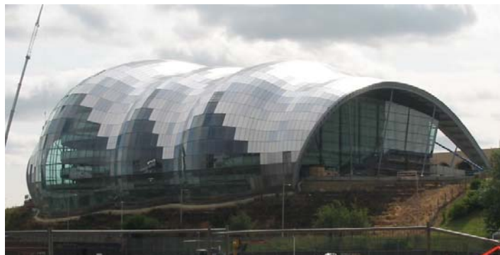
Figura 8. Il cantiere del nuovo auditorium di Newcastle (GB).
