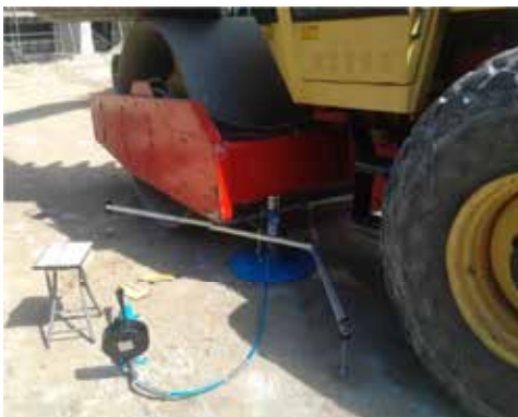
Esecuzione di una prova su piastra
