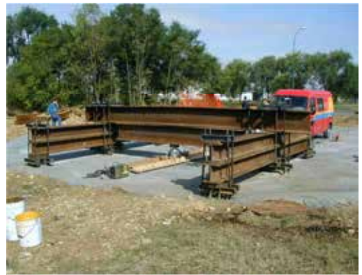
Contrasto ancorato ai pali adiacenti
