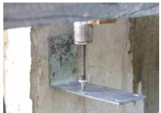
Sensore di cedimento
