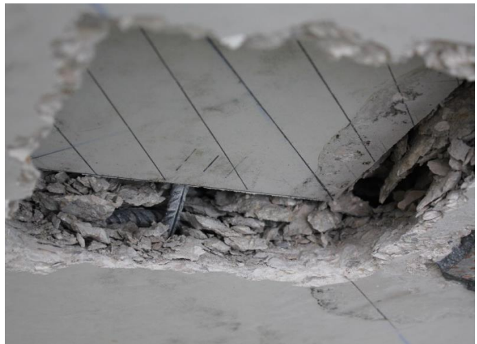
Vista inferiore di una lastra collassata per punzonamento
